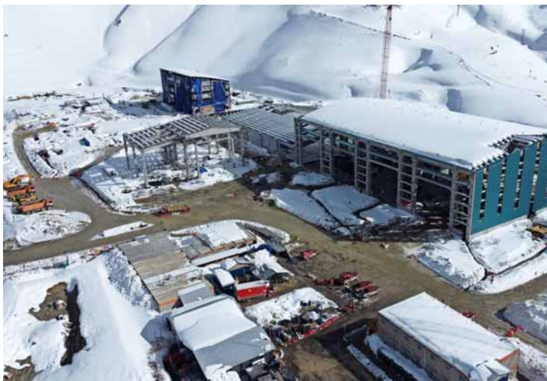
Transformación Tecnológica e Integración BIM. Truck Shop Codelco Andina: Un complejo único en el mundo de prefabricados de hormigón a 3.700 metros de altura.
