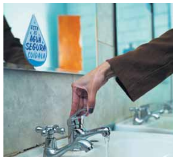
Instalación de proyecto Agua Segura en Escuela Capilla de Caleu en Til Til.
